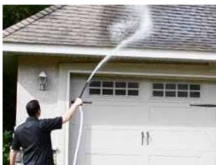
Soft wash Lavaggio facciate
