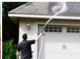
Soft wash Lavaggio facciate
